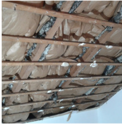
Aktueller Zustand der alten Dachdämmung
